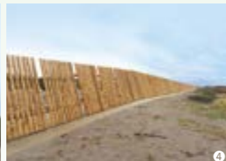
① 海岸に連なる森林には飛砂防備などの機能を有する保安林が必要だ。この現場は2.69ヘクタール。まずは砂丘を重機を用いて整地を行う地拵え作業から始める ② 「防風垣」の杭を打つ、樋浦潤平さん ③ 樋浦さんが作業する奥に見えているのは、昭和60年に植林されたクロマツと「防風工」 ④ 海側から「防風工」を見たところ。新潟県産スギ間伐材を利用した「防風工」
